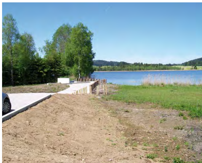
Die fertige Baumaßnahme am Haslacher See.
